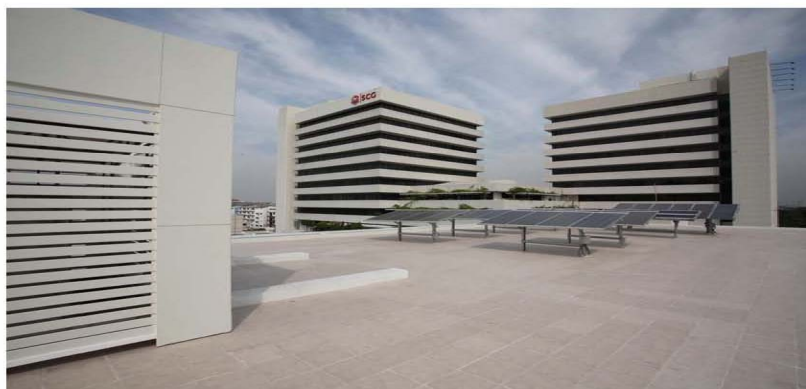
รูปถ่ายหลังการปรับปรุงหลังคา
