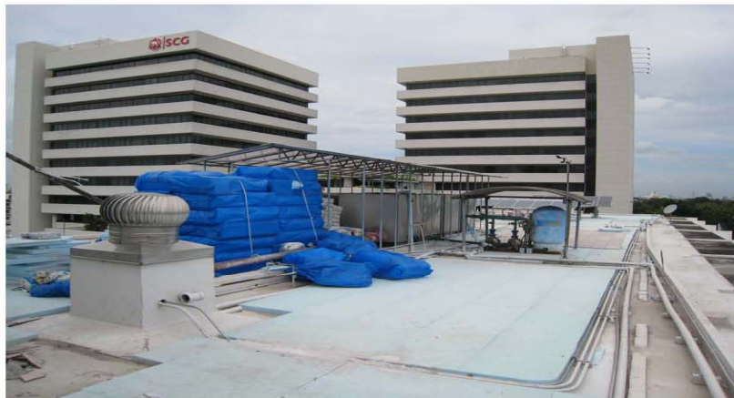
รูปถ่ายระหว่างการปรับปรุงหลังคา
